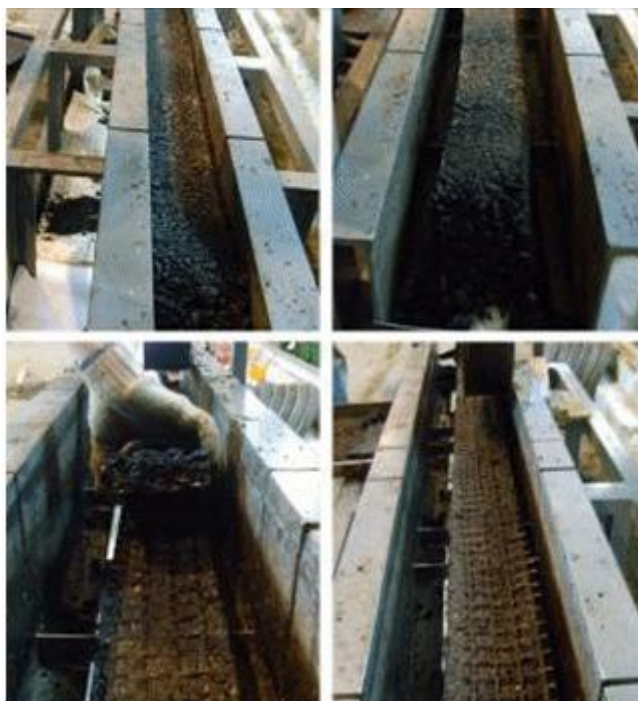
Рис. В.6.2. Процесс извлечения геосетки из конструкции
